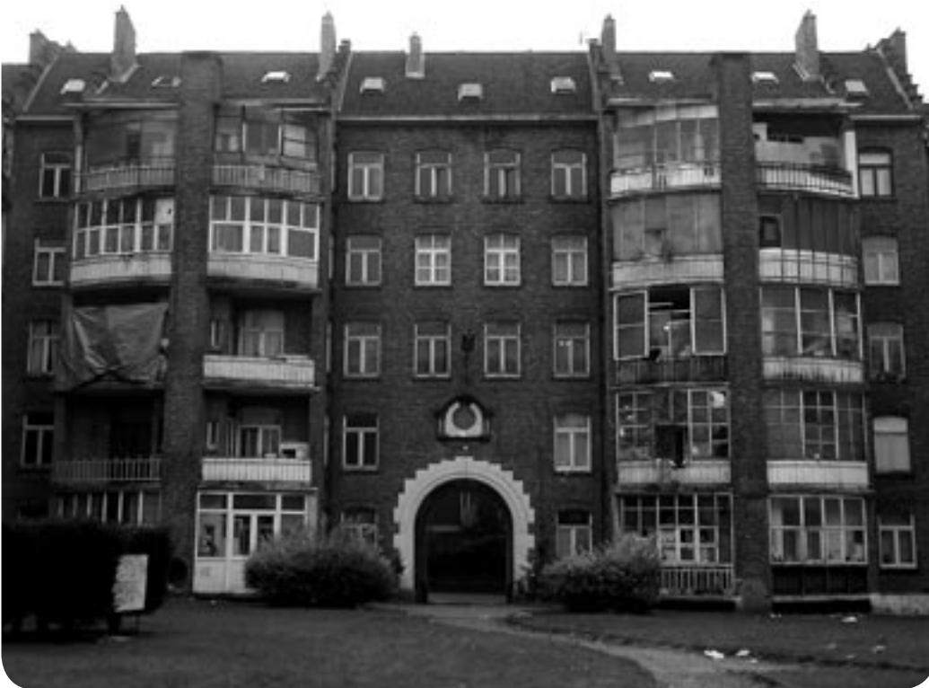
La bonne gestion du parc de logements sociaux est un facteur important pour assurer le caractère durable de l'habitat et la sécurité des ménages bruxellois.
