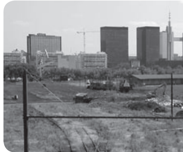
Le site de Tour et Taxis : un site rêvé pour une politique du logement, un espace vert des équipements culturels et
