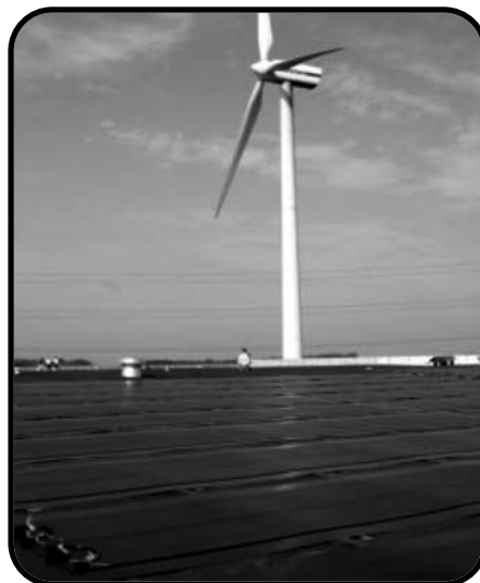
Au centre de distribution de Colruyt à Hal, 8 000 m 2 de panneaux solaires produisent quelque 250 000 kWh par an, soit l'équivalent de la consommation annuelle de 80 ménages.
