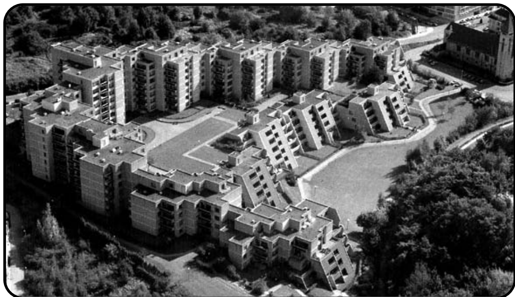
La copropriété La Sauvenière à Woluwe-Saint-Lambert : 250 m 2 de capteurs solaires thermiques combinés à une cogénération à l'huile végétale.
