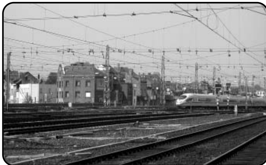
Les maisons de la rue du Progrès menacées de démolition.
