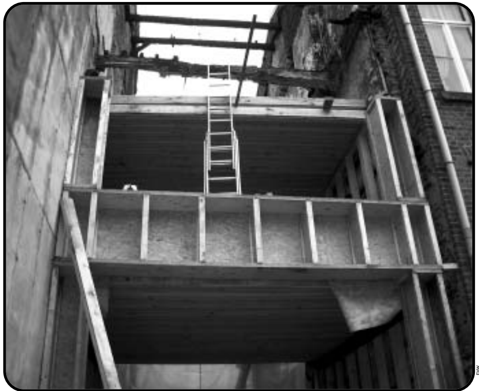
Construction mitoyenne à Verviers. Le bureau d'architecture FHW a mis en œuvre les principes de d'isolation et de suppression des ponts thermiques.
