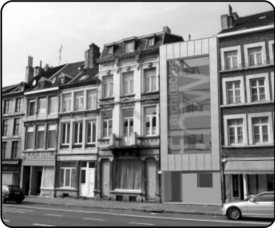
la maison passive. L'ossature en bois permet de répondre aux conditions optimales d'étanchéité,
