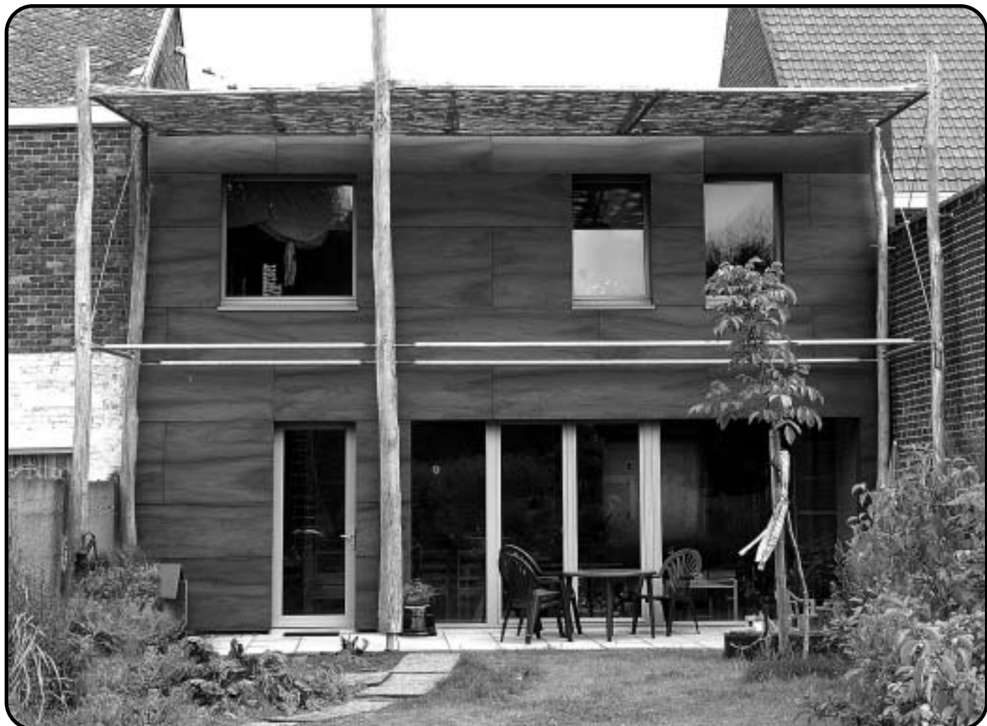
Maison passive à récupération de chaleur. Construite à Heusden par l'architecte Bart Cobbaert.
