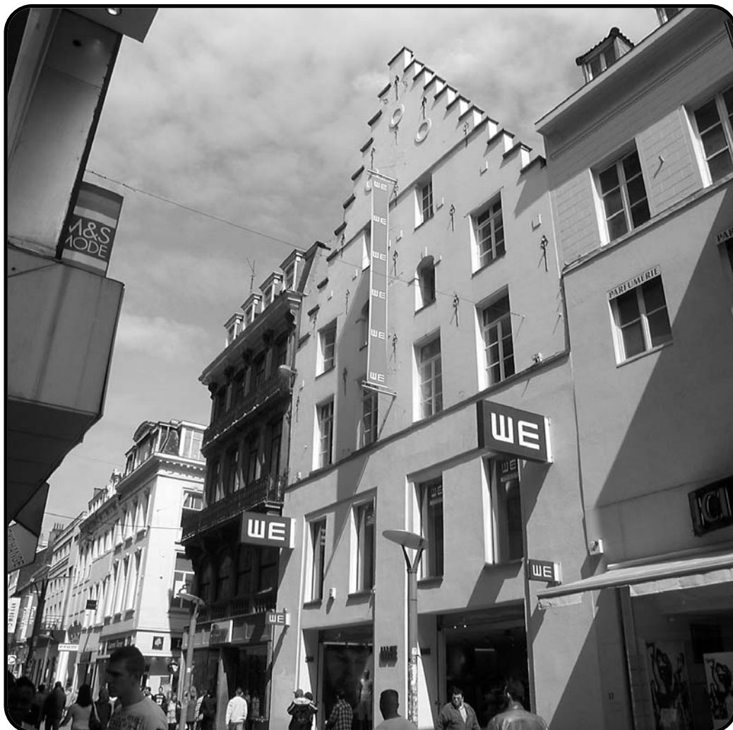
Rue Neuve: les étages au-dessus des magasins offrent un potentiel intéressant pour augmenter le parc de logements.
