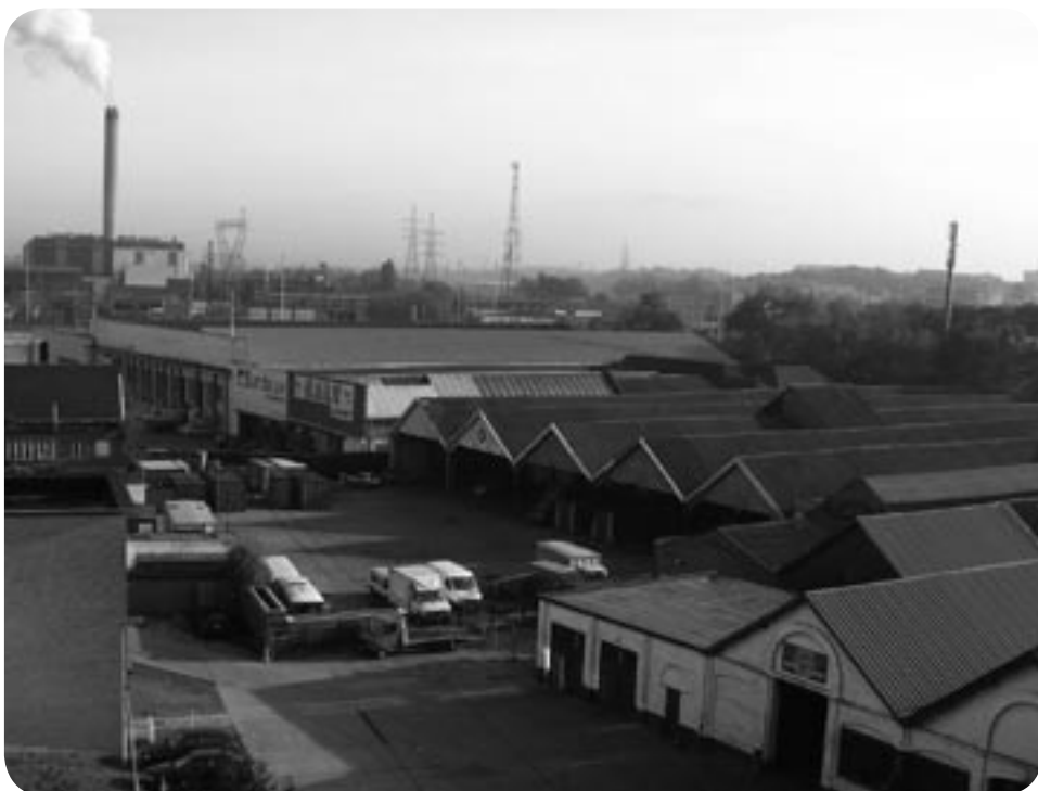
L'ancienne usine Godin : un site à réaffecter et à réinsérer dans l'économie de la ville.
