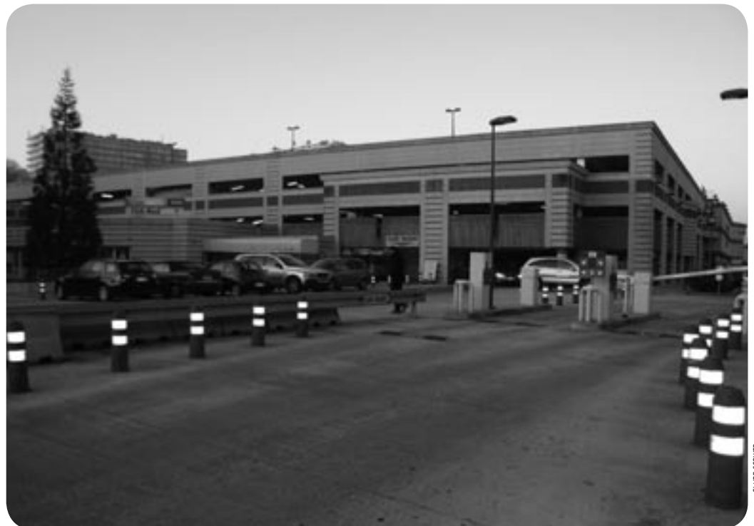
Le parking sud à ciel ouvert viendra se couvrir de 3 niveaux supplémentaires.
