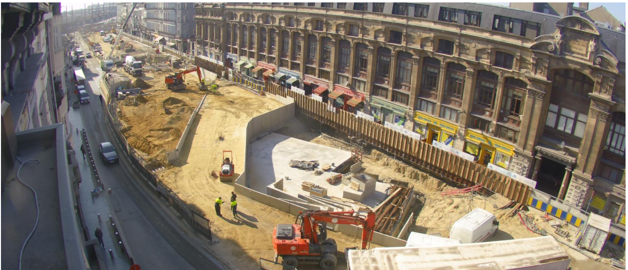
Le chantier de construction de la station « Toots Thielemans » avenue de Stalingrad. Il est encore temps d'éviter de pareils « désagréments » aux habitants et aux commerçants de Schaerbeek et d'Evere.
