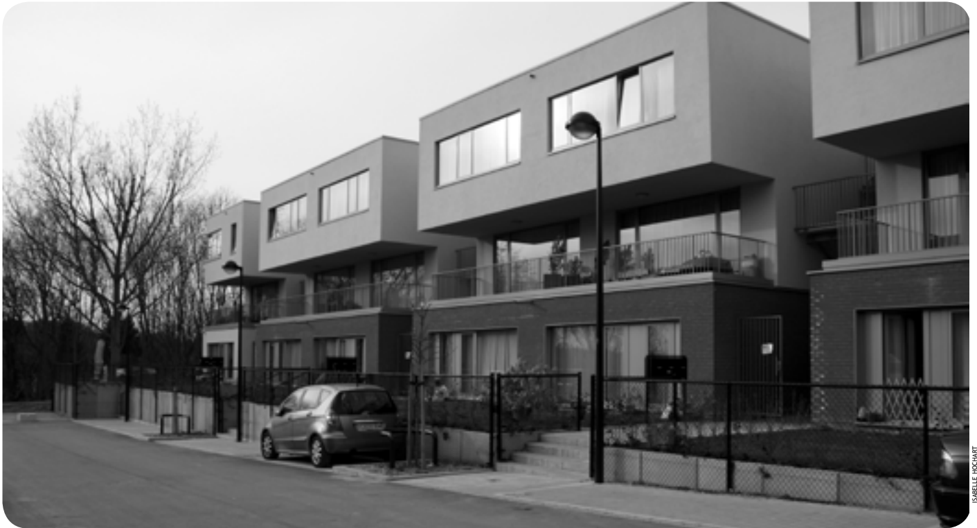
La cité-jardin du Craetbosch regroupe 58 logements répartis dans de petits bâtiments basse énergie.
